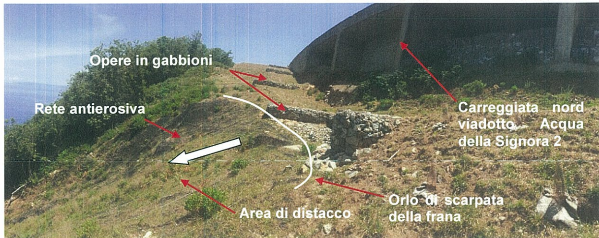
Foto 6.4- Vista delle opere relative agli interventi di mitigazione successivi all'evento franoso, evidenza dell'assetto morfologico dell'area di competenza e del ruolo stabilizzante che presentano tali opere nei confronti del versante
