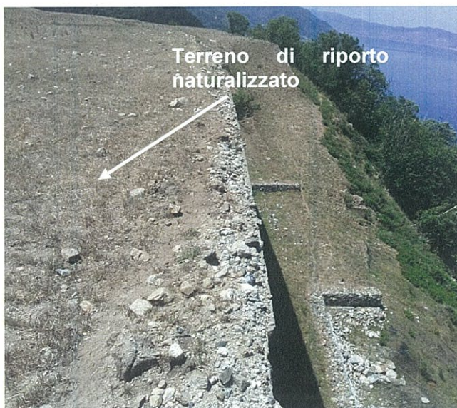
Foto 6.2 e 6.3- Terreni di riporto presenti lungo il vecchio tracciato autostradale, messi in posto per il mascheramento delle opere soggette a demolizione e attualmente ben naturalizzati.
