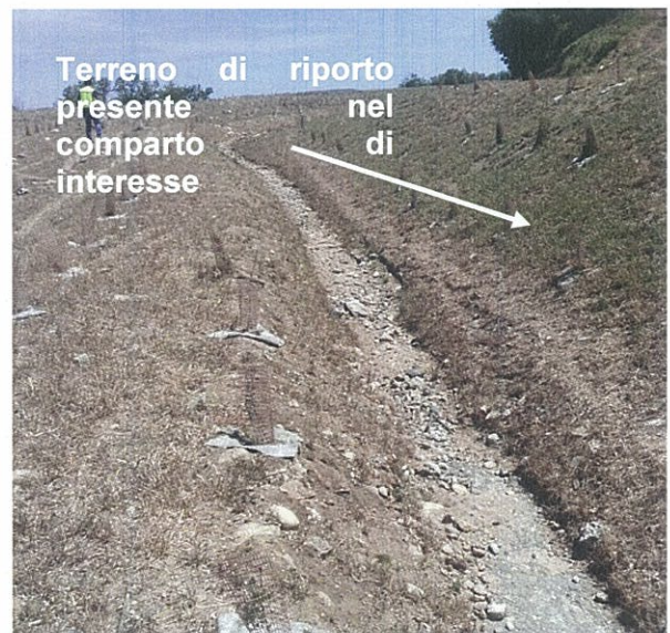
Foto 6.2 e 6.3- Terreni di riporto presenti lungo il vecchio tracciato autostradale, messi in posto per il mascheramento delle opere soggette a demolizione e attualmente ben naturalizzati.
